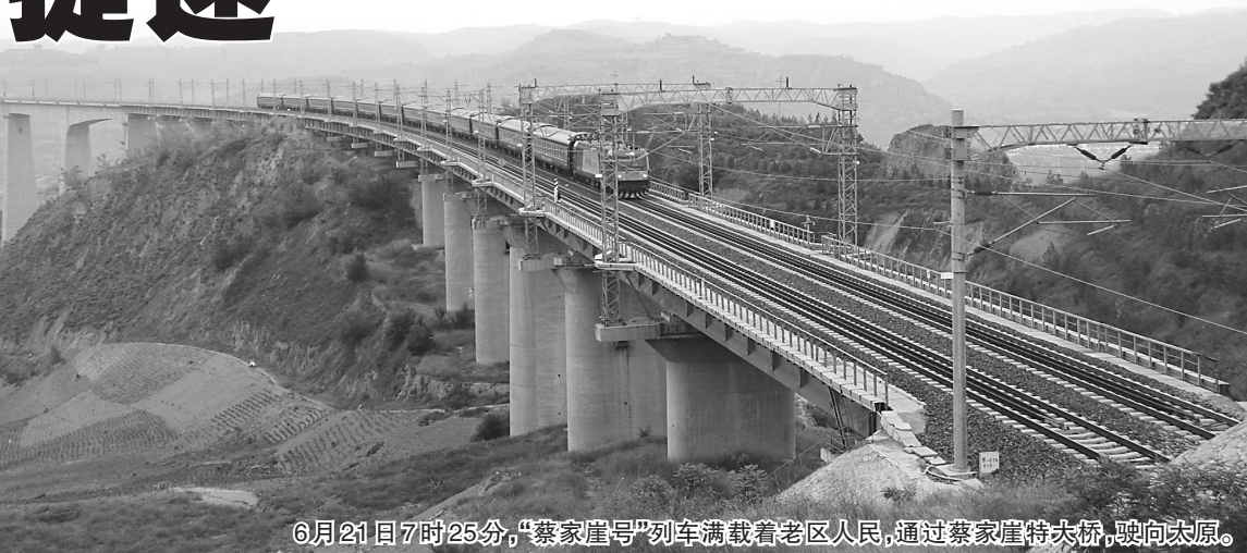
6月21日7时25分,“蔡家崖号”列车满载着老区人民,通过蔡家崖特大桥,驶向太原。
