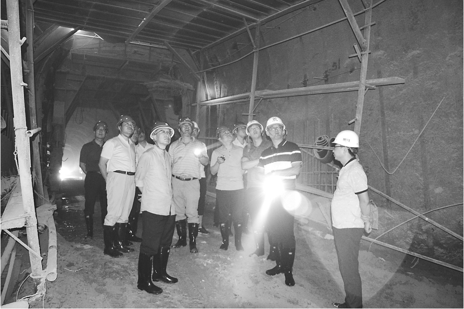
图为与会人员参观山西中部引黄工程15标项目部44号施工支洞工地。 记者 李小明 摄
