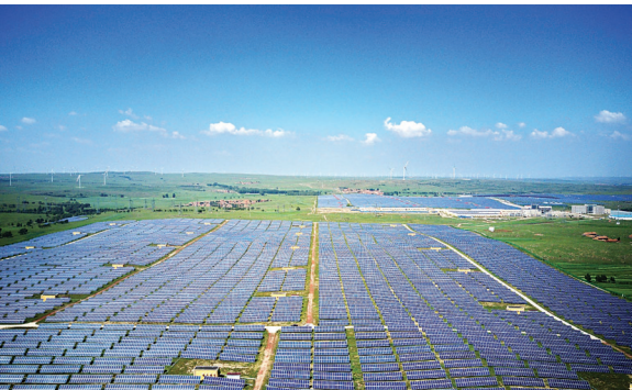
这是河北省张北县境内的国家风光储输示范工程光伏发电场（8月1日无人机拍摄）。新华社记者 杨世尧 摄
