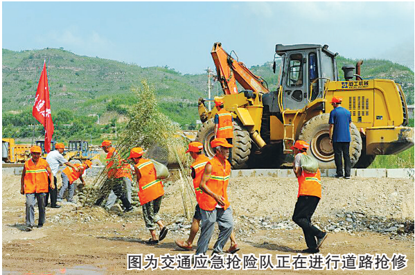
图为交通应急抢险队正在进行道路抢修
