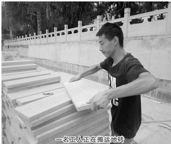
一名工人正在搬运地砖
