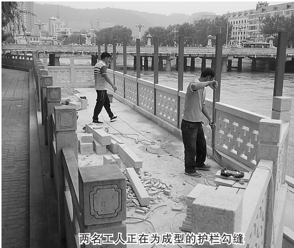
两名工人正在为成型的护栏勾缝
