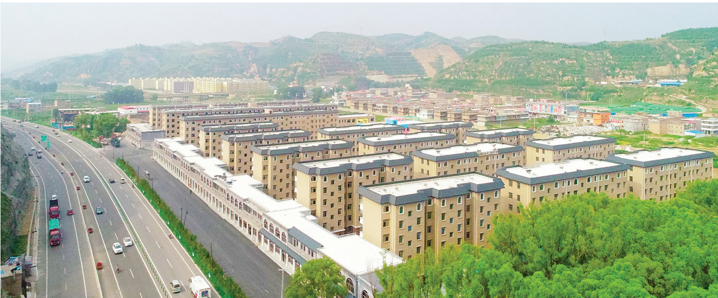
图为临县城南移民搬迁工程。 刘建荣 摄
