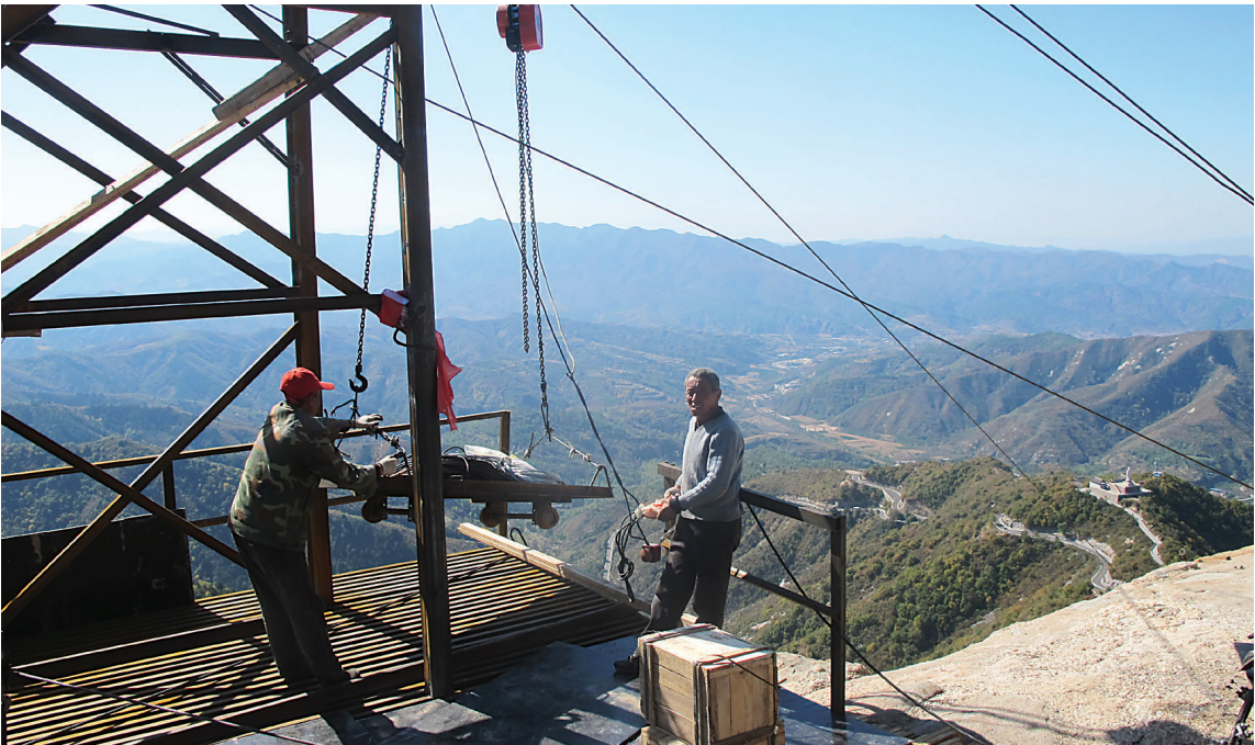
北武当山又名真武山,古称龙王山,位于方山县境内,吕梁山脉中段。北武当山风景名胜区内由72峰、36崖、24涧组成。它集“雄、奇、险、秀”于一身,是吕梁山的一颗明珠,系我国北方道教圣地。 据介绍,北武当山景区的特点是原生态和自然美,让游客可以充分领略大自然的鬼斧神工。近日,景区对基础设施进行改扩建,努力将北武当山的品位提高到一个新层面。图为改造工程施工现场。 闫卫星 白洁 摄
