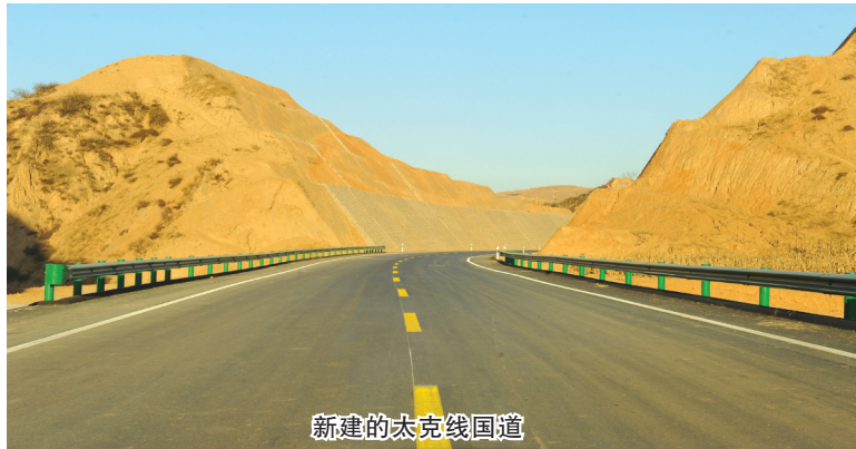
新建的太克线国道
