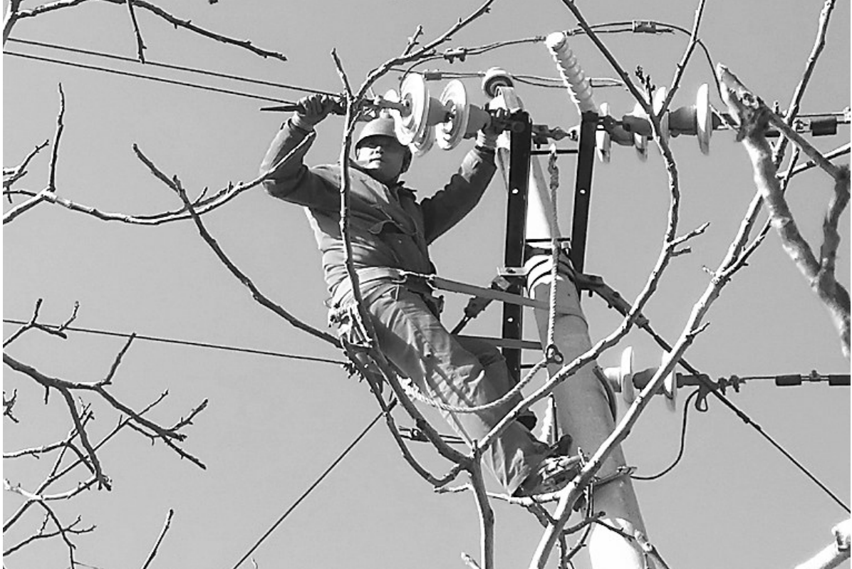
1月23日,地电方山分公司巡检人员对县城线路进行检查。连日来,地电方山分公司巡检人员对全县的线路、设备等进行逐条逐项检查,确保春节期间全县城乡居民安全可靠用电。肖继旺 樊慧敏 高军 摄
