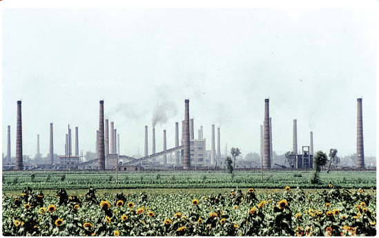
整改前梧桐萍乡炉
