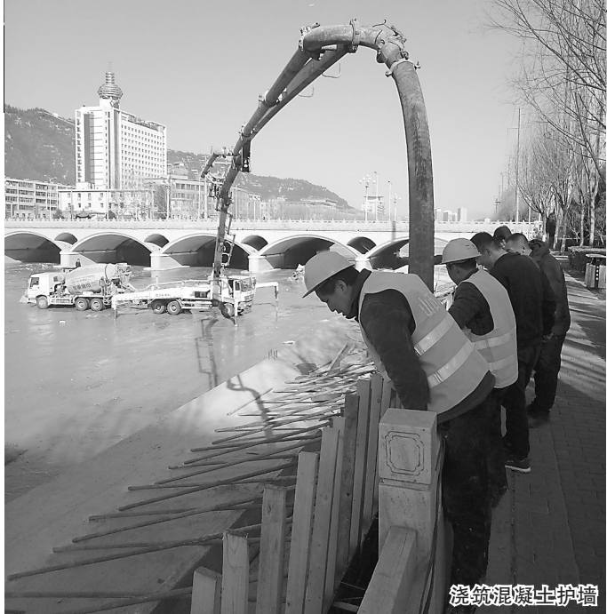
浇筑混凝土护墙
