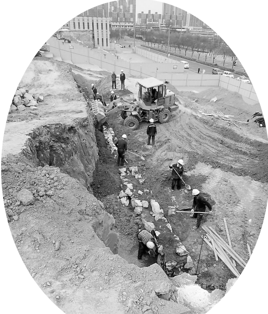
热火朝天的站前绿化提升施工现场面
