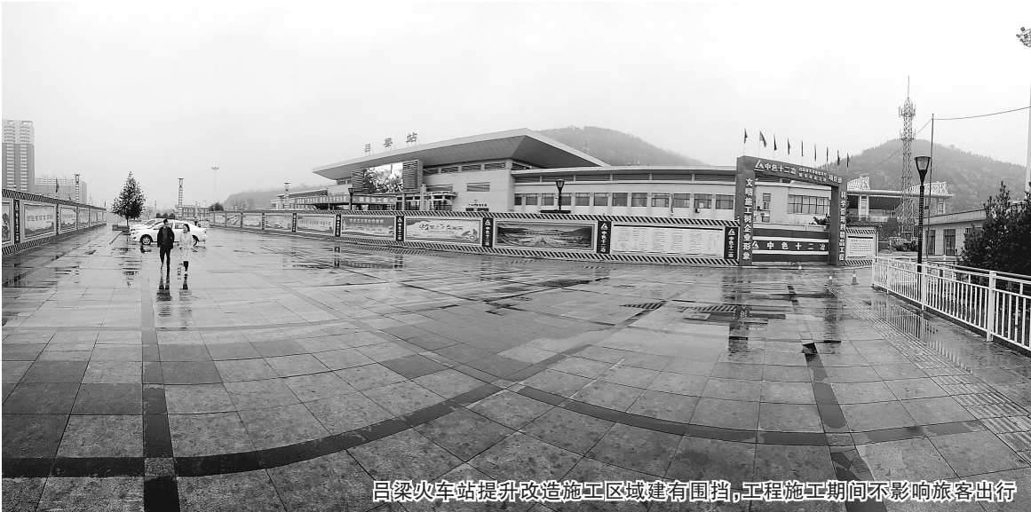
吕梁山火车站提升改造施工区域建有围挡，工程施工期间不影响旅客出行
