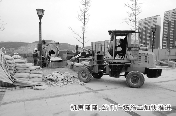
机声隆隆，站前广场施工加快推进
