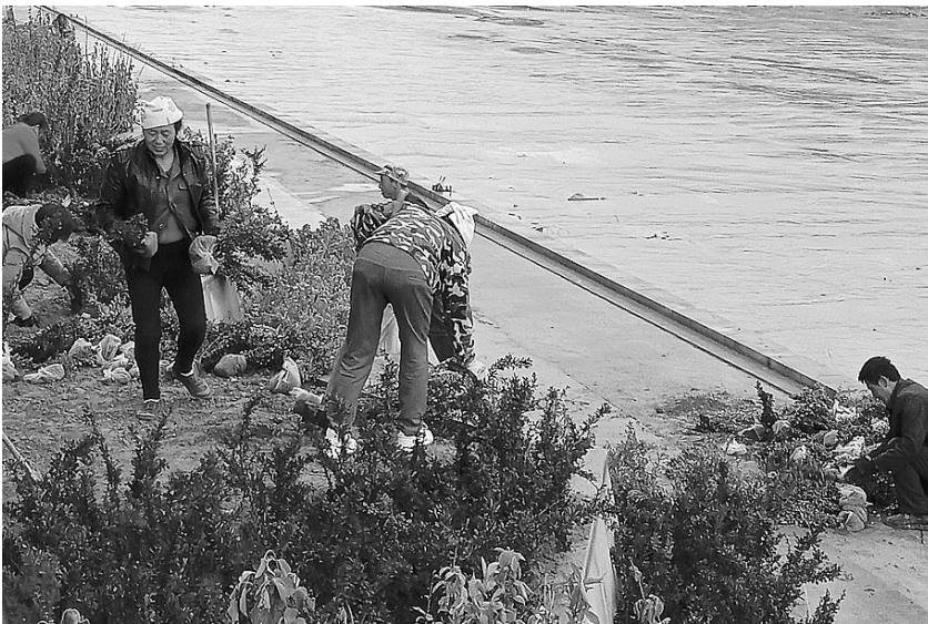
近段时间,离石区滨河南路新建人行通道绿化工程正在有序推进,建成后将是市民休闲锻炼的好去处。图为工人们正在栽植景观树、花卉。 李玉平 摄
