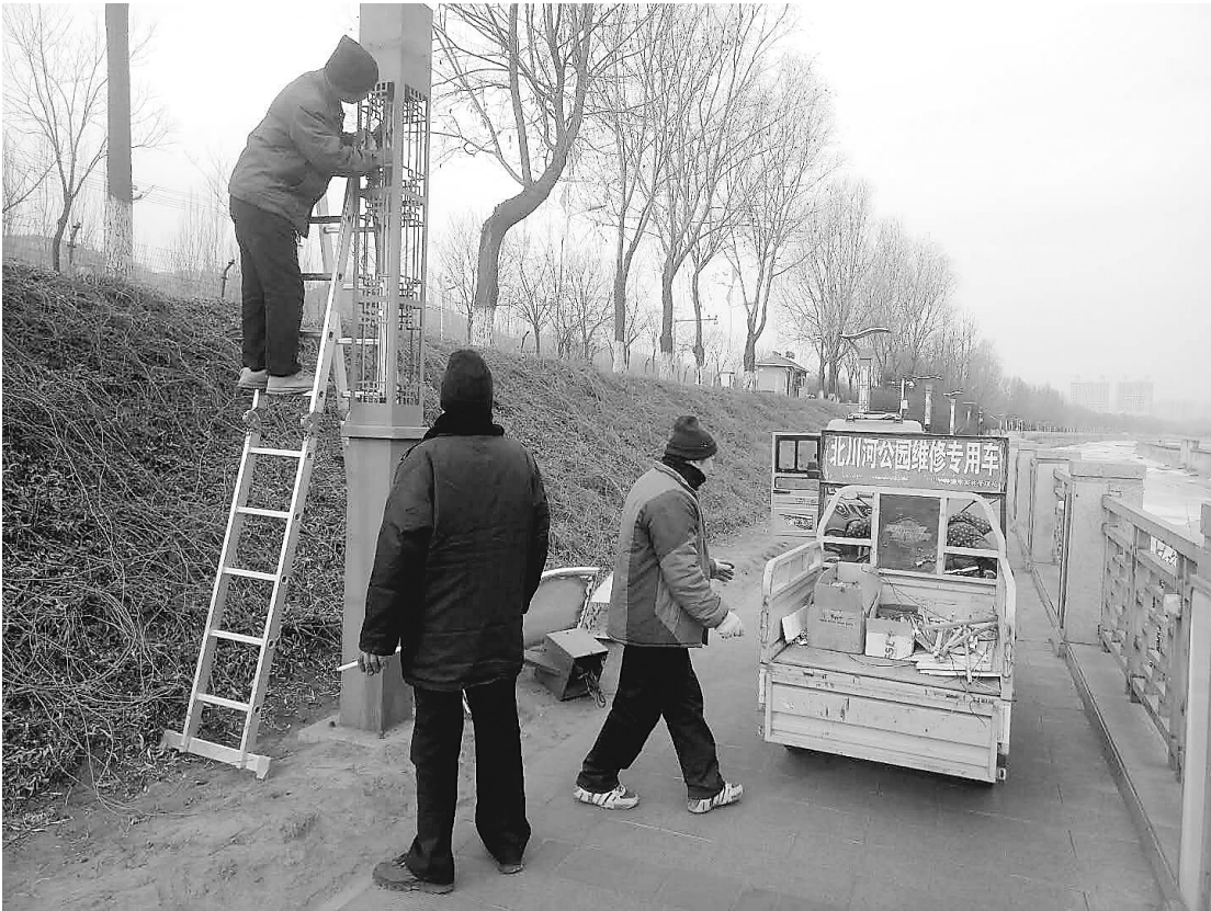
为全力保障公园、广场路灯的运行质量，美化、亮化城市夜景，营造文明城市氛围，市政路灯部门持之以恒做好路面亮化的巡查和路灯设施日常维护，受到市民的好评。图为路灯维护人员在北川河公园维修损坏的路灯。 记者 郭炳中 摄
