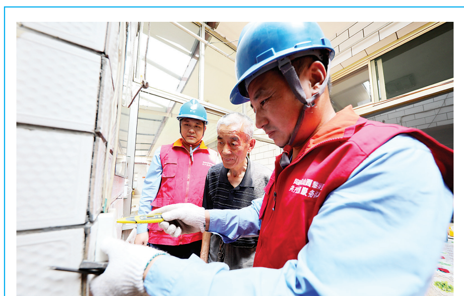
高阳镇供电所加快电动车基础设施建设,服务绿色出行
