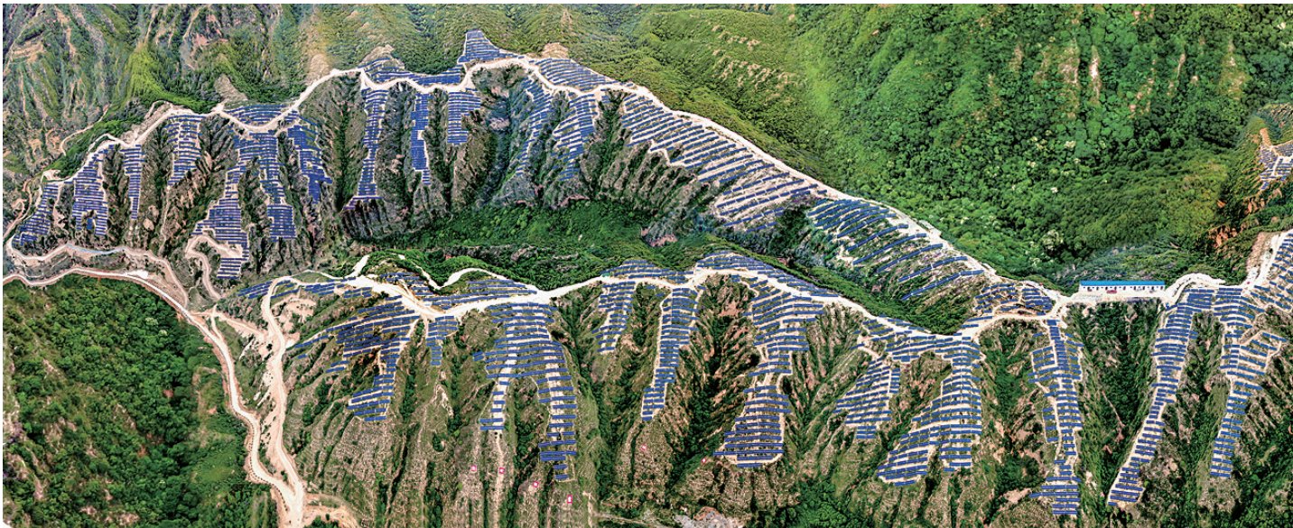
临县30兆瓦集中式光伏电站项目是该县规模最大的一座电站。该项目位于临县城庄镇境内,分三期建设,总体规划容量90兆瓦。2018年11月28日,总投资近2.3亿元的中电投30兆瓦集中式光伏电站开始并网发电,年发电量约4200万千瓦时。据测算,该项目每年可为临县带来收益700余万元,在项目运营的前三年,每年将从收益中拿出300万元专项资金用于扶贫,帮扶临县1000户贫困户,每户年可增收3000元。图为规模宏大的临县30兆瓦集中式光伏电站项目。 记者 刘亮亮 摄
