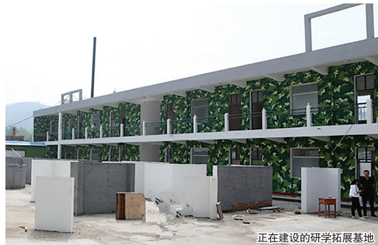
正在建设的研学拓展基地
