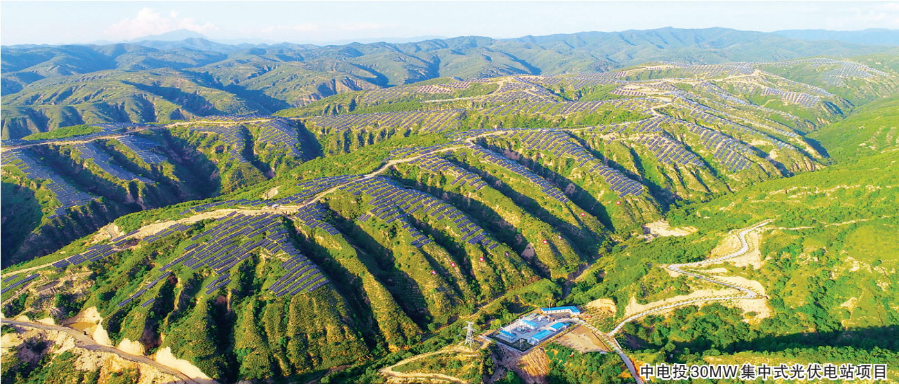
中电投30MW集中式光伏电站项目
