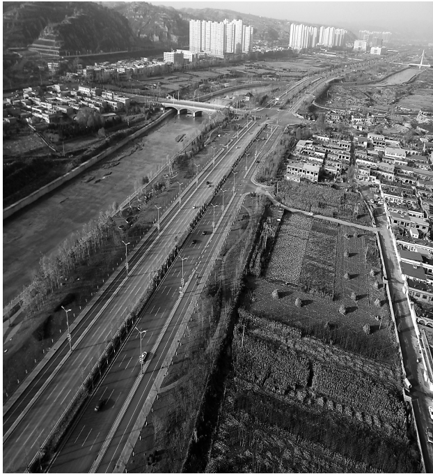
近年来,吕梁新区坚持“稳中求进,久久为功”的思路,将创新、协调、绿色、开放、共享的新发展理念贯穿到吕梁新区建设中,以更大手笔、更高标准、更高起点统筹推进建设进度,新区面貌日新月异。图为以吕梁大道为轴心的吕梁新区发展势头强劲。 记者 郭炳中 摄
