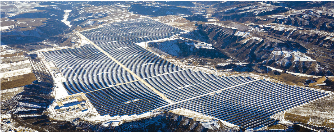
12月7日,无人机拍摄的方山县大武镇孙家山光伏扶贫电站。 孙家山35兆瓦集中式光伏扶贫电站占地约938亩,总投资2.6亿元,年均发电4550万度,收益2184.91万元。电站收益将用于公益岗位、小型公益事业、产业发展以及为贫困劳动力创造更多就业岗位等。 记者 刘亮亮 摄
