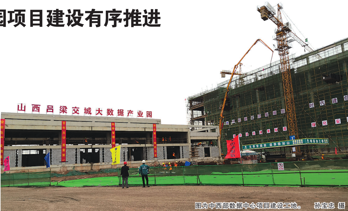
图为中西部数据中心项目建设工地。 孙宝忠 摄
