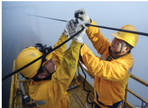
1月15日,在南昆铁路百威段单线电气化路线上,工人在检修接触网。
