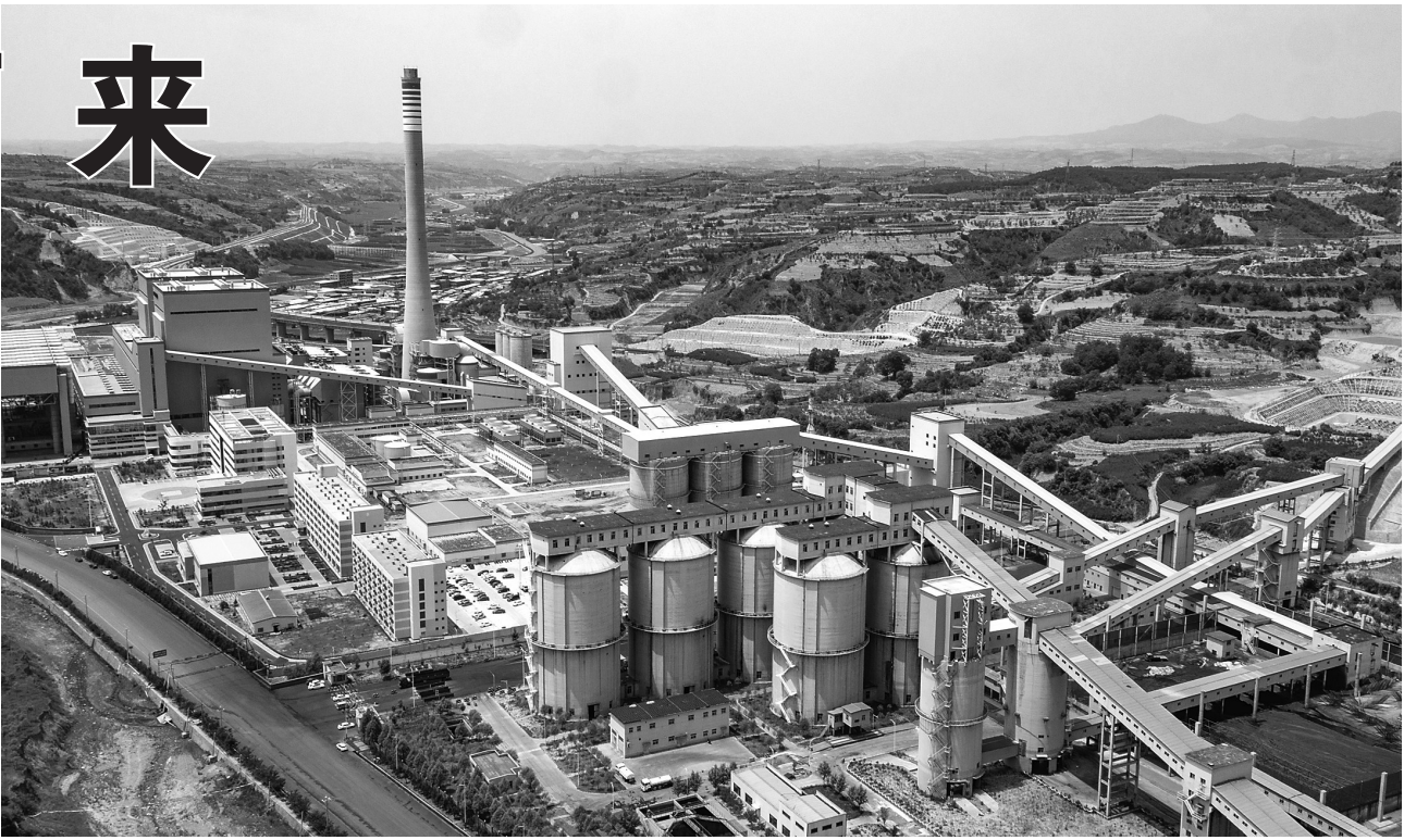
位于临县城镇镇的山西京能吕临发电有限公司项目。
