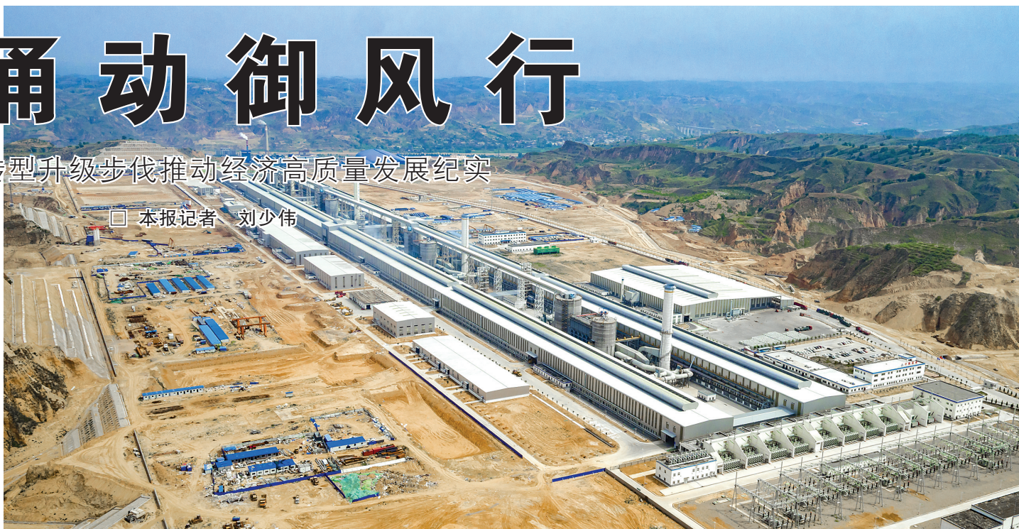
山西中润一期43.2万吨电解铝项目采用国内先进的节能型电解技术,4套干法电解烟气净化系统,配套阳极组装和铸造车间等。总规划建设100万吨合金铝和3×660MW自备电厂,目前项目已全部建成。
