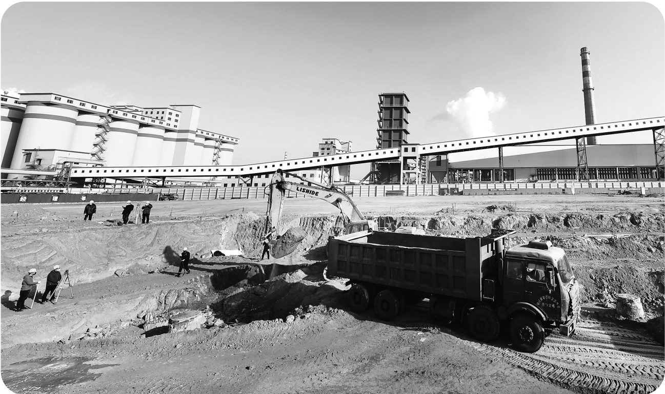
近日,山西孝义经济开发区金岩能源科技二期253万吨/年7.1米顶焦集化项目施工现场一派繁忙景象。当前,孝义市在全力抓好疫情防控的同时,积极统筹协调资源,有序抓好企业生产经营,全力以赴确保疫情防控、安全生产两不误。张建益 摄
