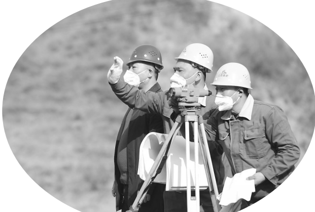
山西路桥建设集团有限公司技术人员在施工现场测量放样
