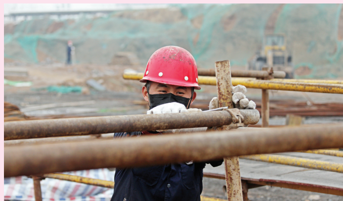
2月24日,金晖抗菌剂系列项目现场,施工人员进行为开工做准备。该项目总投资10.5亿元,投产后可带动当地产业转型发展,新增解决就业人员200余人;项目达产后可实现销售20-25亿元。
