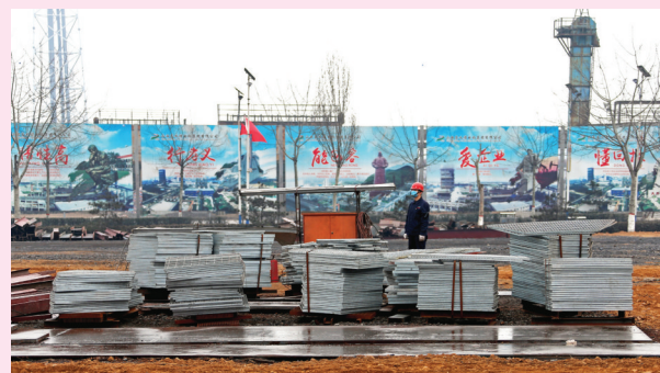
2月24日,东义年产25万吨甲醇联产8万吨合成氨项目施工现场,工程车辆正排队施工。该项目概算总投资116700万元,投产后预计营业收入57825.62万元,利税15813.5万元,可带动周边300多人就业。
