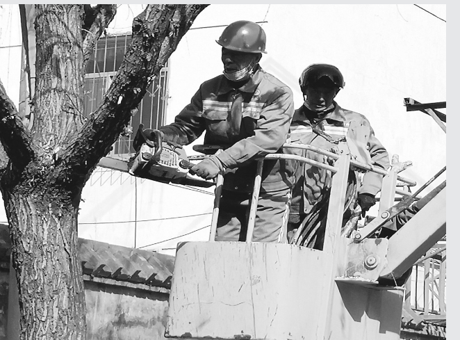
园林工人站在高空升降车上,利用油锯对行道树进行修剪。
