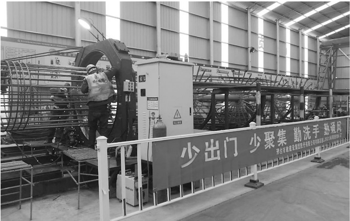
祁离高速公路是我市重点工程，在复工复产关键阶段，该项目第十三标段坚持做到疫情防控和复工复产“两手抓、两不误”，严格落实相关工作精神，科学制定防疫和施工计划，在保证安全的前提下，全面掀起施工高潮。图为该标段进行封闭施工。 李海峰 摄
