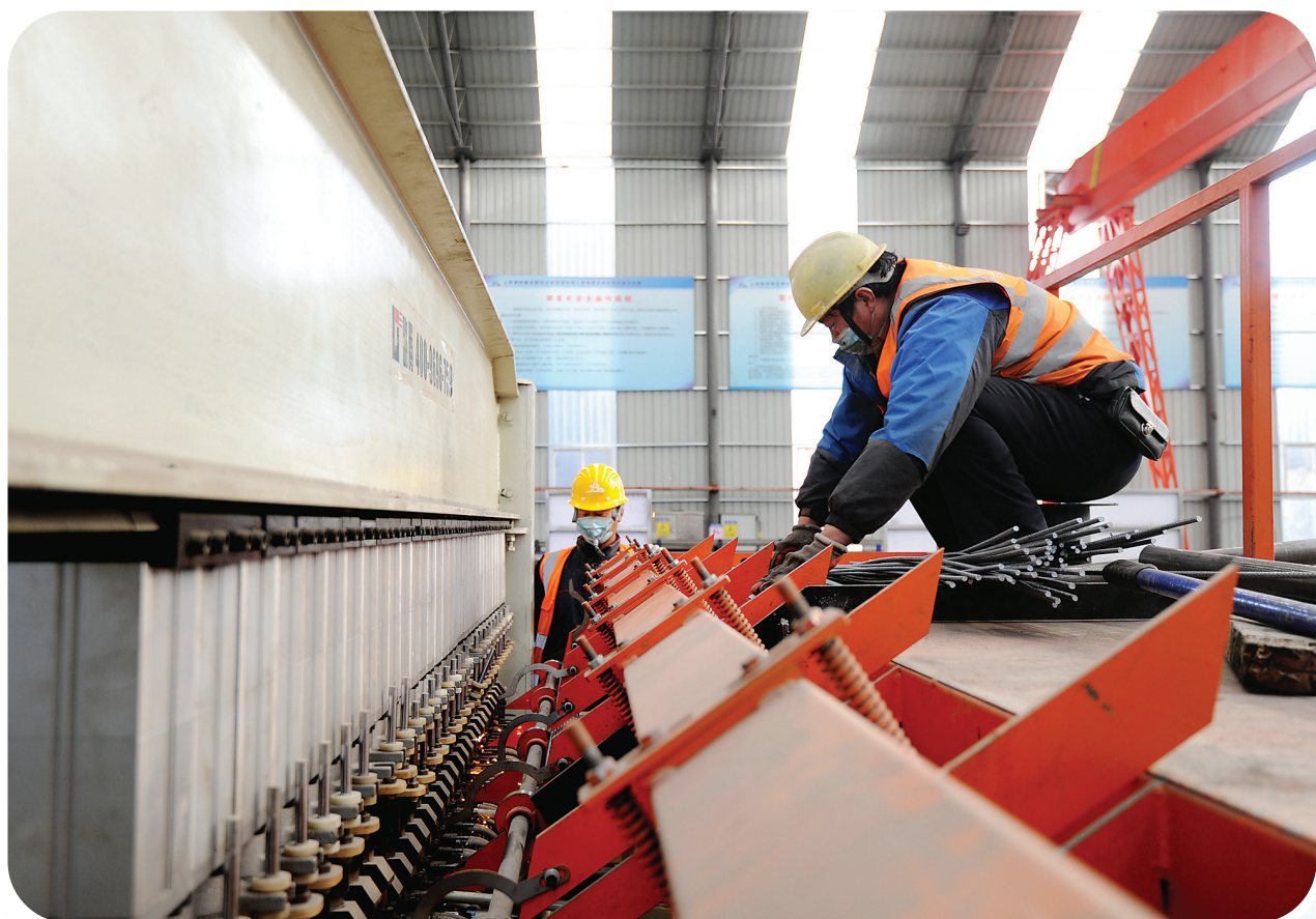
在国道209改线工程五分部钢筋加工车间,工人在焊网机上作业
