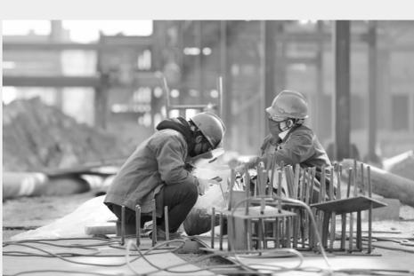
焦炉煤气综合利用项目施工现场,工人在电焊作业
