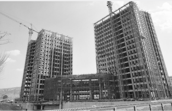
财经中心外立面装修
