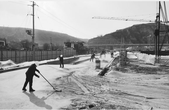
新城一中工人正在平整场地
