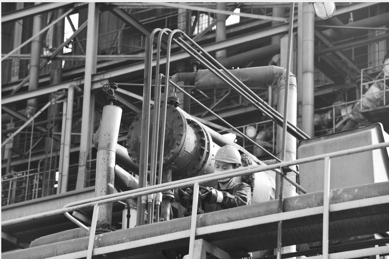
春暖花开,万物复苏。连日来,交城县在持续做好疫情防控工作的同时,积极抓好企业复工复产工作,推动各企业抢抓机遇,提速快跑,奋力夺取疫情防控和经济社会发展双胜利。图为交城经济技术开发区内,山西宏特煤化工有限公司的工人们正在高达100多米的焦炭塔上紧张地忙碌着。
