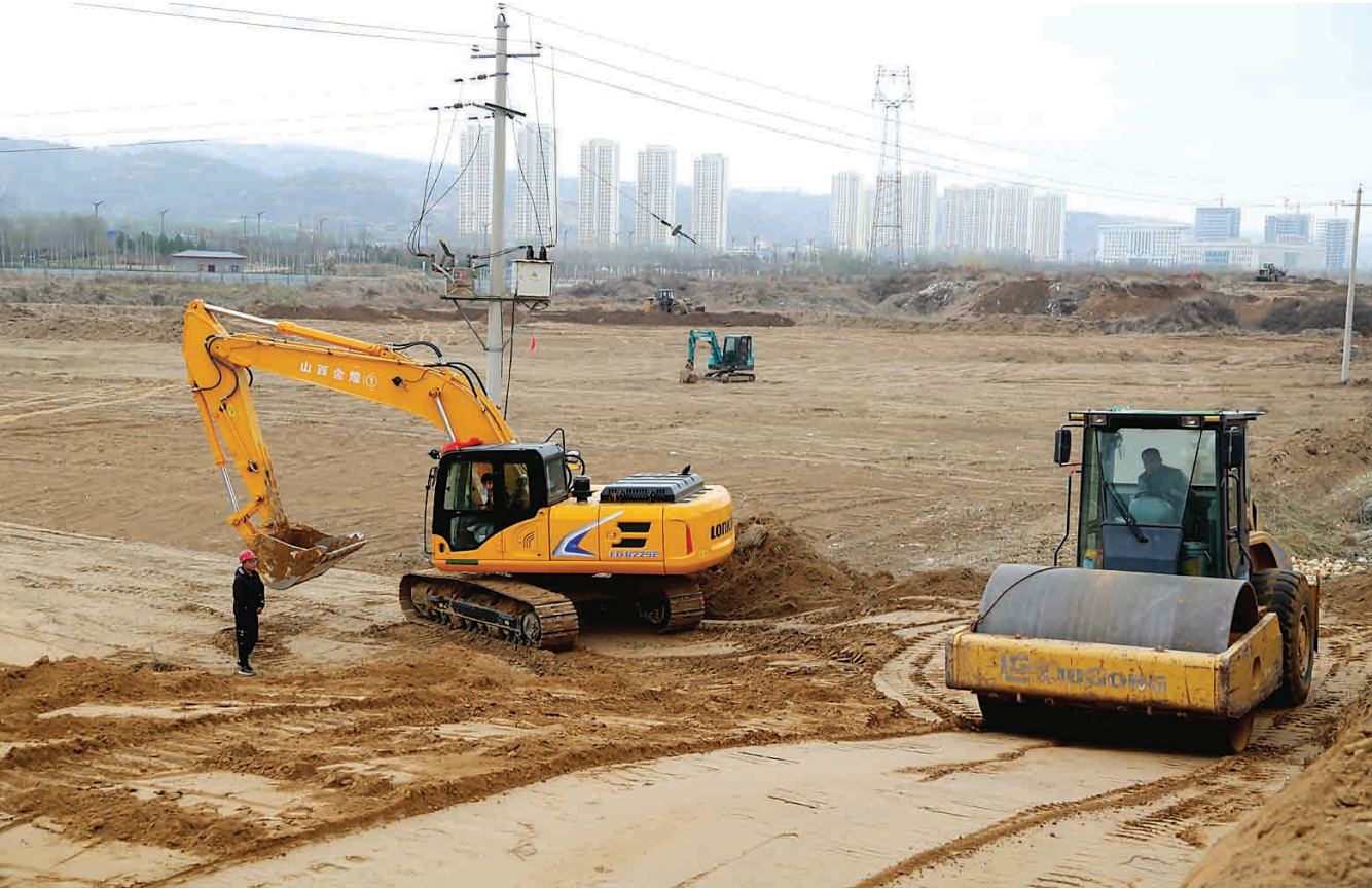
今年以来,离石区紧盯吕梁新区项目建设不放,创造优良环境服务项目建设,全力以赴推动项目建设。图为七号湖项目施工建设现场。姜利文 摄
