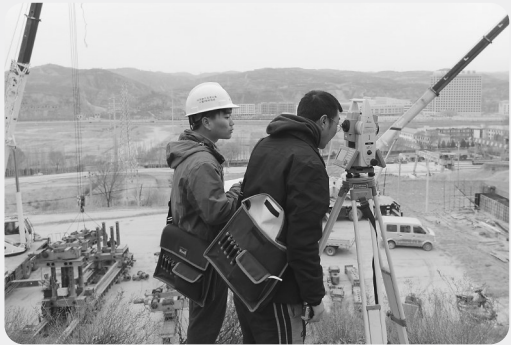
中铁集团的技术人员在施工现场测量放样
