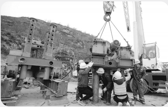
工人在静兴高速公路项目土建七标段组装架梁机
