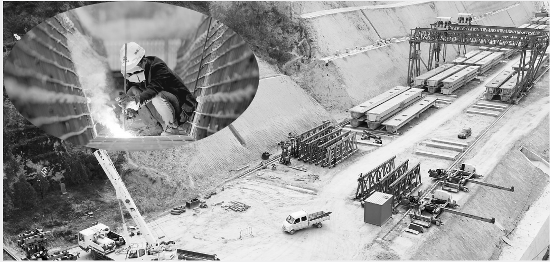
静兴高速公路项目土建七标段施工现场
