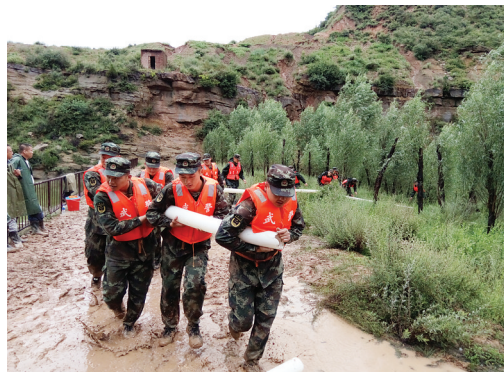
每年防汛期间,驻市部队对河堤坝进行加固抢险,有效避免了人员伤亡和财产损失。
