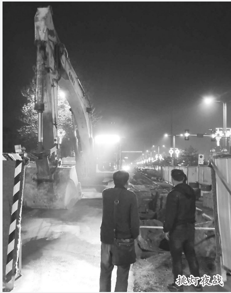
滨河南路施工
