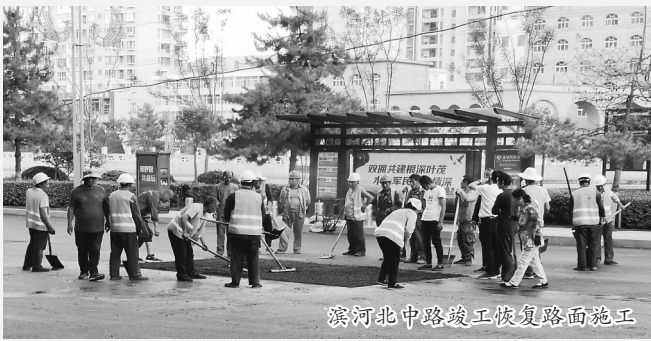
滨河北路施工
