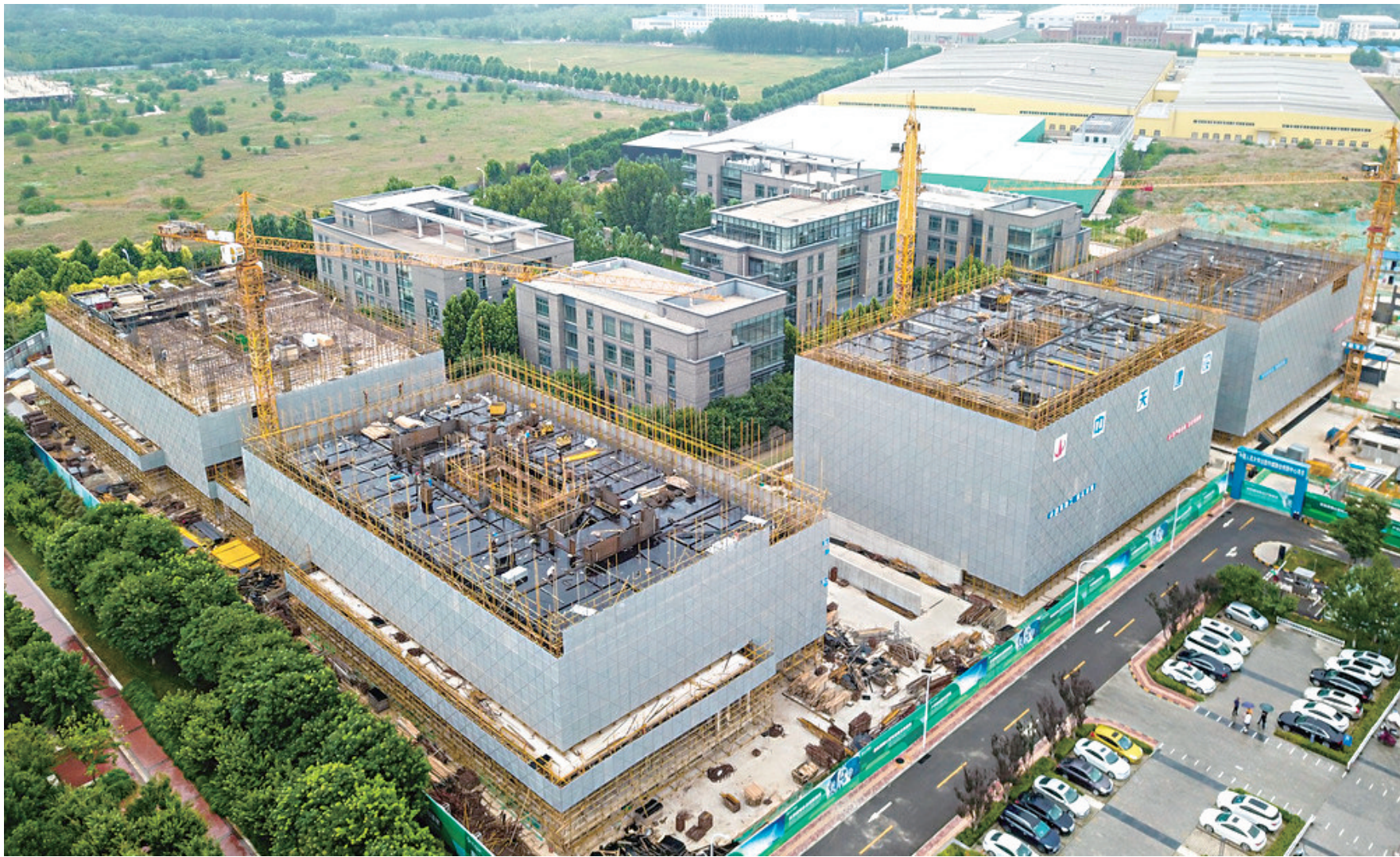
7月2日,工作人员在河北省重点建设项目——中国人民大学新校区大厂拓展区项目作业(无人机照片)。连日来,在做好疫情防控的前提下,河北省大厂回族自治县稳步推进重点项目建设。截至目前,该县亿元以上在建项目20个,计划总投资259亿元;亿元以上计划新开工项目4个,预计总投资11.96亿元。
