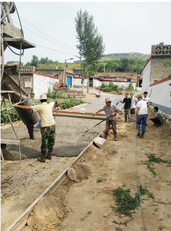
县交通局扶贫工作队为麻地会乡冯家庄村修桥筑路。
