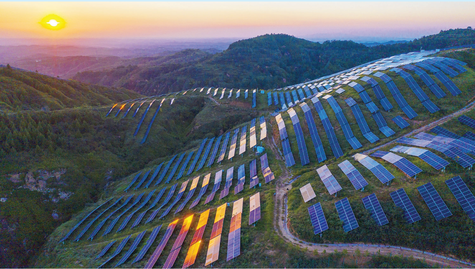
方山县杜家会7.59兆瓦光伏电站位于峪口镇杜家会村，占地180亩，投资5300万元。该项目于2018年5月23日开工建设，同年9月30日并网发电。年发电量约986.7万度，年均地收益可达到600万元。该项目采用“智能光伏+科技农业”的全新一代农光互补模式，将光伏支架抬高到3米以上，桩距跨度南北10米，东西5米，采用单组件安装、科学设计倾斜度等创新技术，可在光伏板下种植蔬菜、花卉、中药材等作物，既能满足农业机械化耕种，又能满足光伏下面农作物种植的阳光光照条件。
