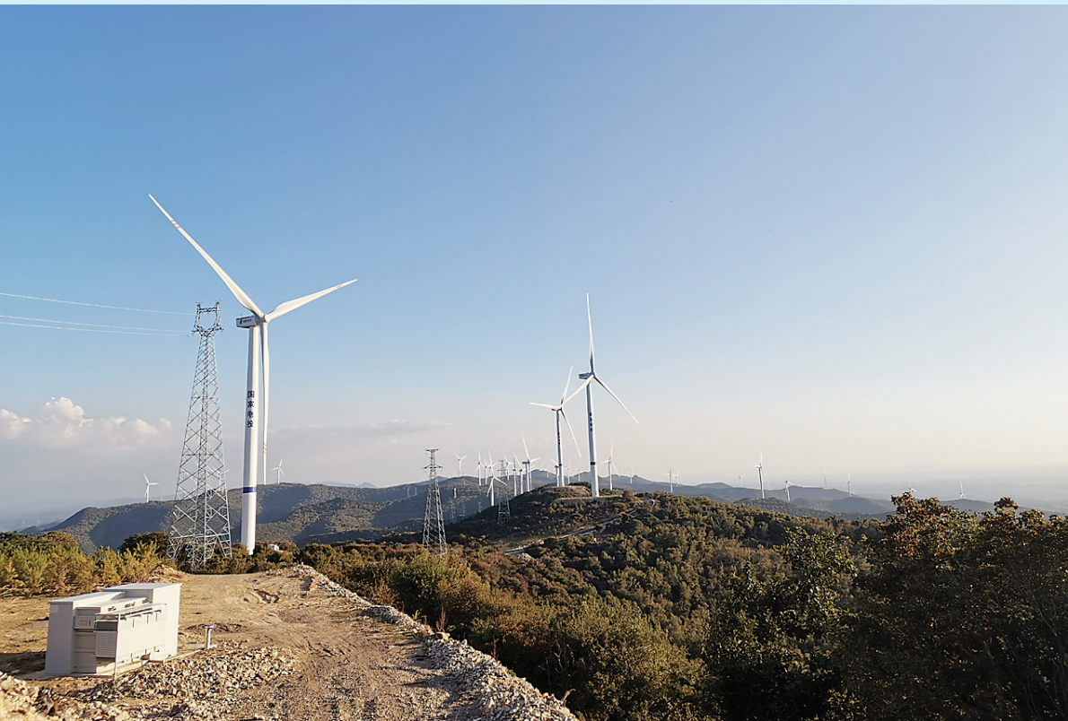
棋盘山风电场99.5MW风电建设工程,由国家电投内蒙古公司投资建设,场址位于交口县水头镇,每年可为电网提供清洁能源19721x104kw·h,与燃煤电厂相比,以供电标煤煤耗644.74g/kw·h计算,每年可节约6.36x104t煤,相应每年可减少多种有害气体和废气排放。 李小明 摄
