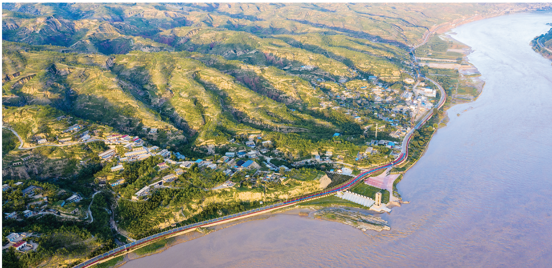
黄河一号旅游公路临县段项目
