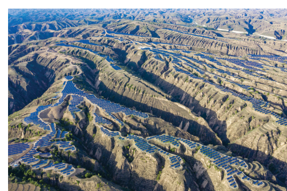
临县白文34MW光伏扶贫电站项目
