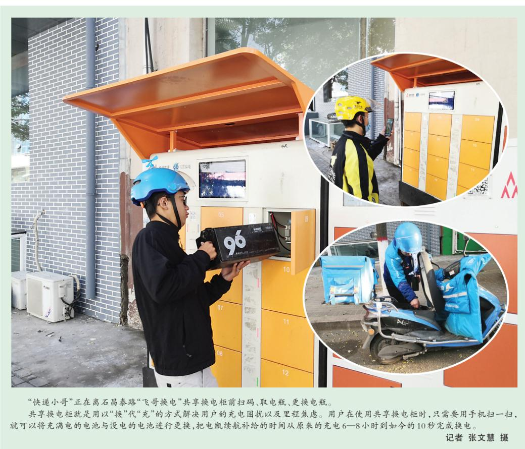
“快递小哥”正在离石昌泰路“飞哥换电”共享换电柜前扫码、取电瓶、更换电瓶。共享换电柜就是用以“换”代“充”的方式解决用户的充电困扰以及里程焦虑。用户在使用共享换电柜时,只需要用手机扫一扫,就可以将充满电的电池与没电的电池进行更换,把电瓶续航补给的时间从原来的充电6—8小时到如今的10秒完成换电。 记者 张文慧 摄
