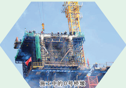
施工中的0号桥墩
