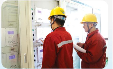
孝义市供电公司变电站巡检员在35KV楼西变电站对站内二次设备进行检查并做好记录。
