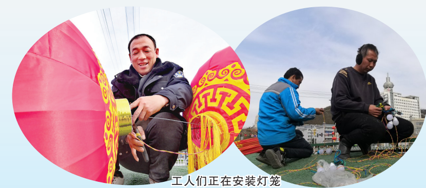
工人们正在安装灯笼
