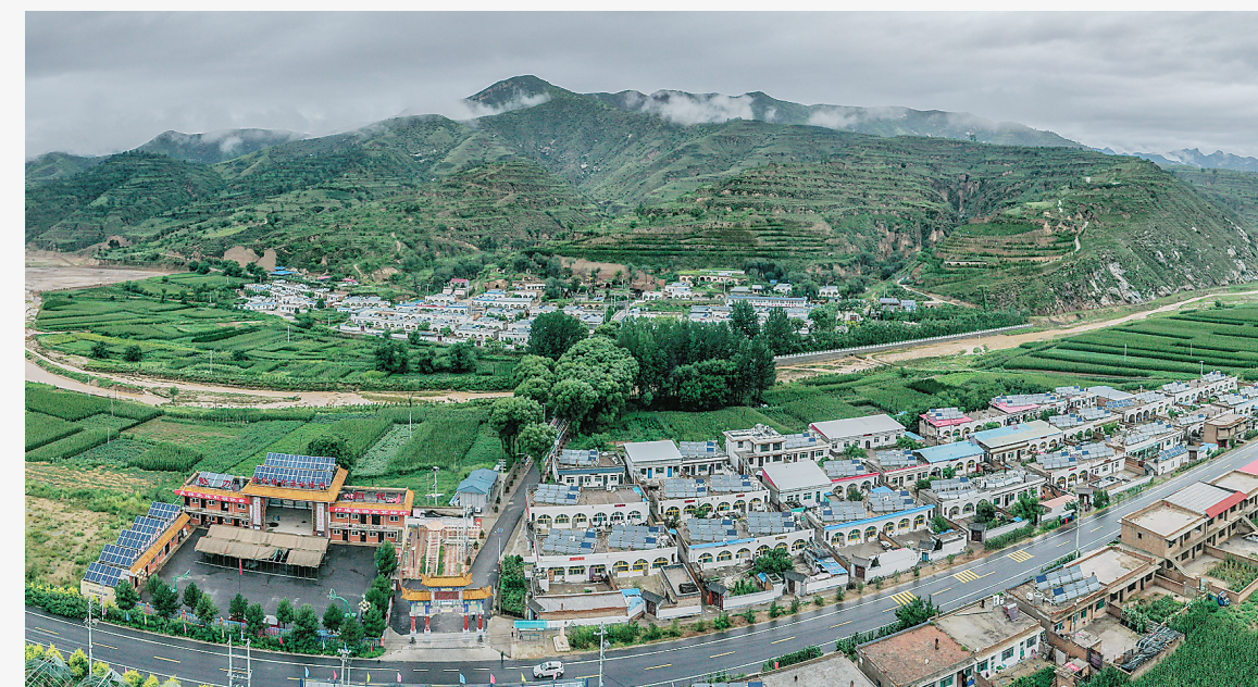
离石区信义镇光伏扶贫项目
