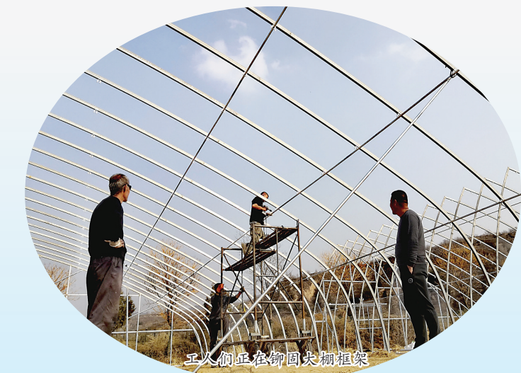
工人们正在铆固大棚框架
