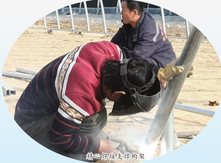
精心焊接支撑构架
