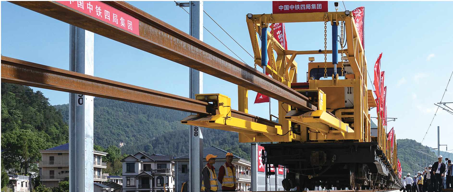
国内首套无砟轨道智能铺轨机组在张吉怀高铁建设中成功运用。这是5月8日在张吉怀铁路施工现场拍摄的长钢轨智能推送车。
