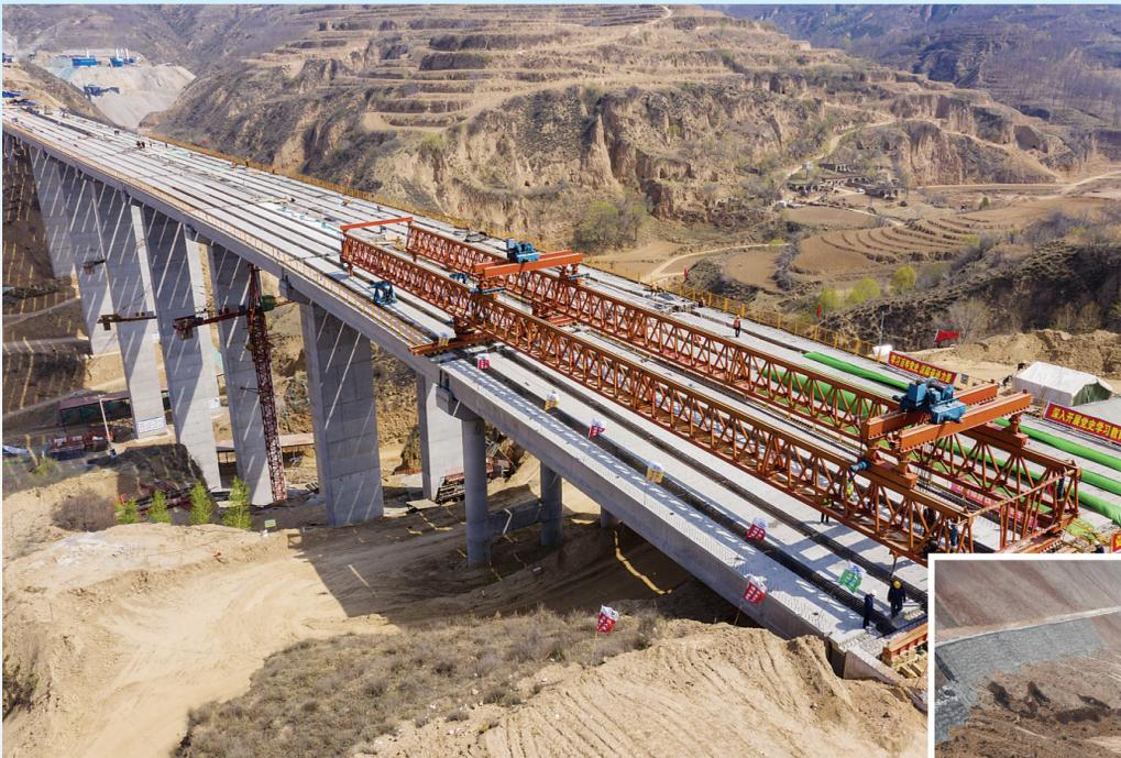
4月22日,国道209改线项目方山县丰泉寺大桥第90片40米T梁安全落位,标志着该桥顺利贯通。丰泉寺大桥于2019年10月16日开工,大桥总长368m,最高墩柱61m,最深桩基52m,预计5月31日前丰泉寺大桥桥面将全面完工。G209吕梁改线工程总投资71.84亿元,自开工累计完成投资44.6亿元。截至目前,全线路基土石方工程已基本完成,全线共设桥梁48座,已贯通5座,全线共设隧道10座,已贯通3座。 记者 刘亮亮 摄
